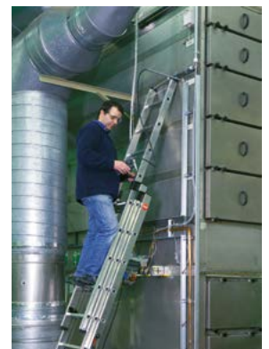
Kontrolle des Filterturms
