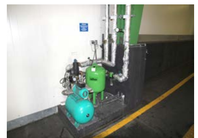
Regenwassereinspeisung
