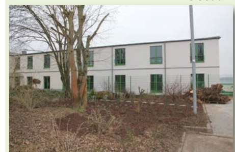
Extension du bâtiment administratif
