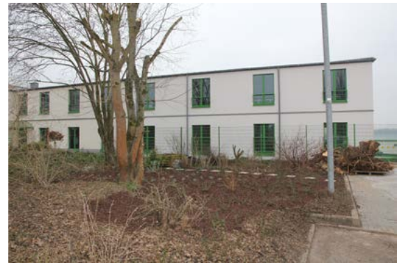
↑ Fläche vor dem Verwaltungsgebäude
