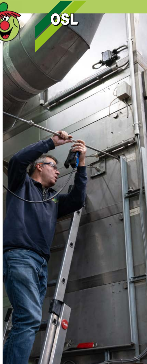
↑ Mesure dans la tour de filtration
