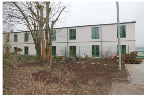
↑ Fläche vor dem Verwaltungsgebäude
