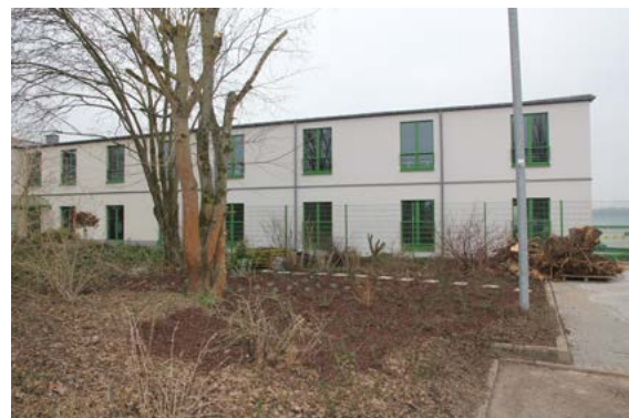
↑ Esplanade devant le bâtiment administratif
