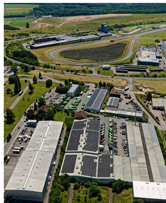
↓ Luftbild Standort Colmar-Berg mit PV-Anlage
